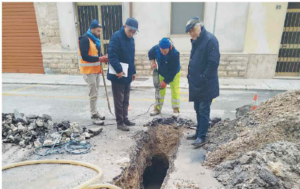
Acqua inquinata Gli scavi per effettuare i controlli a gennaio Foto archivio
