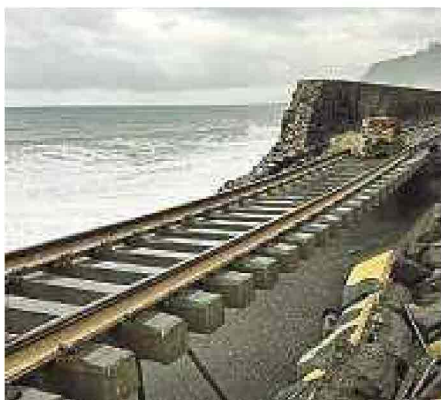
Scaletta Zanclea Binari rimasti «sospesi» senza più terrapieno
