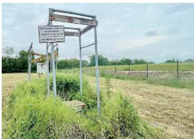
Passirano. Uno dei piezometri situati accanto alla discarica Vallosa
