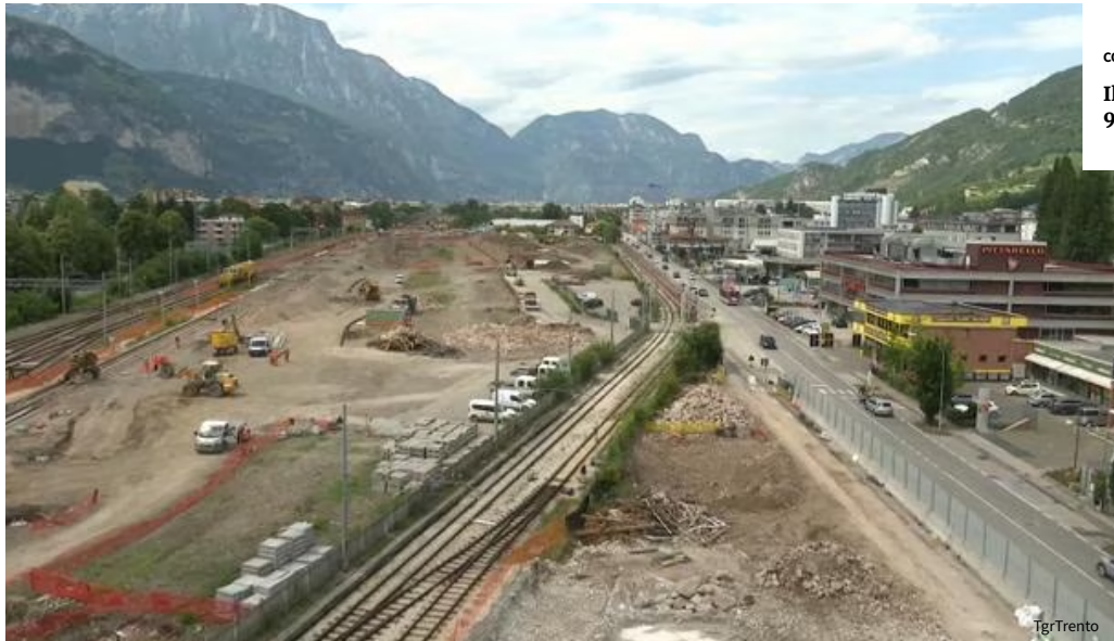
Jardo dall'alto sul cantiere allo scalo Filzi di Trento
