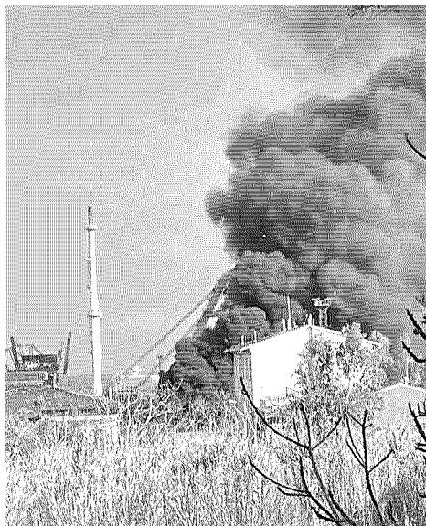
La colonna di fumo finita a ridosso delle abitazioni
