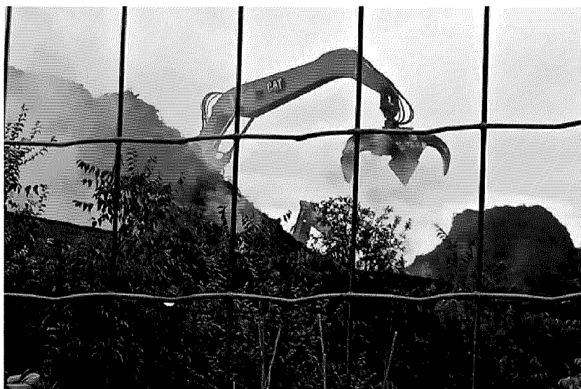
Le operazioni di smassamento all'interno dell'impianto di via Vespucci in zona Valdaro (Foto Turina)
