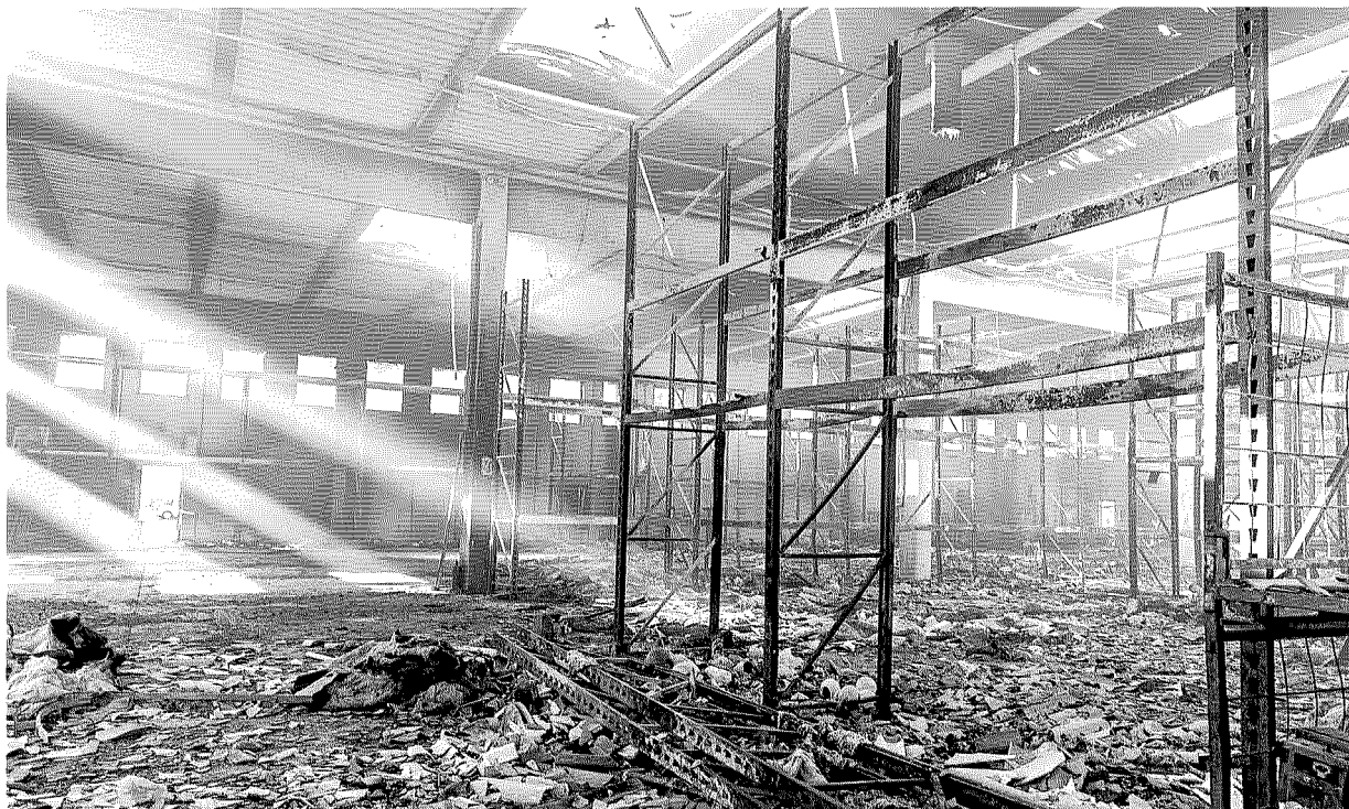
L'interno dello stabilimento completamente distrutto dalle fiamme a Francenigo di Gaiarine (Foto Macca)
