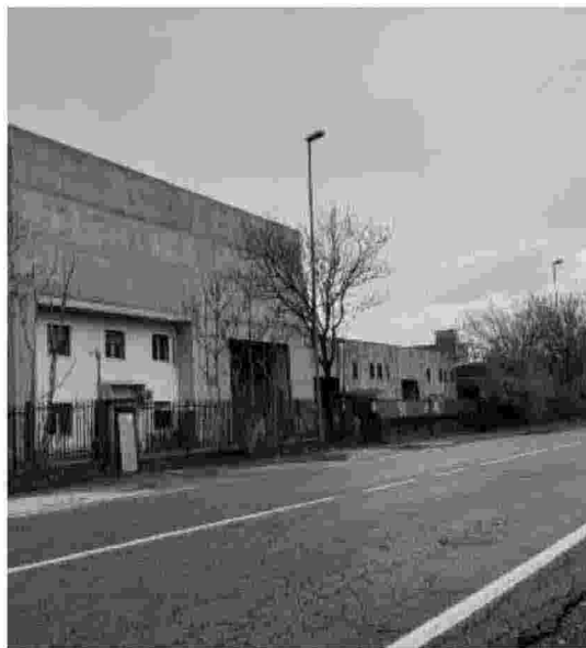
La zona di Castenedolo dove si sono registrati problemi ambientali
