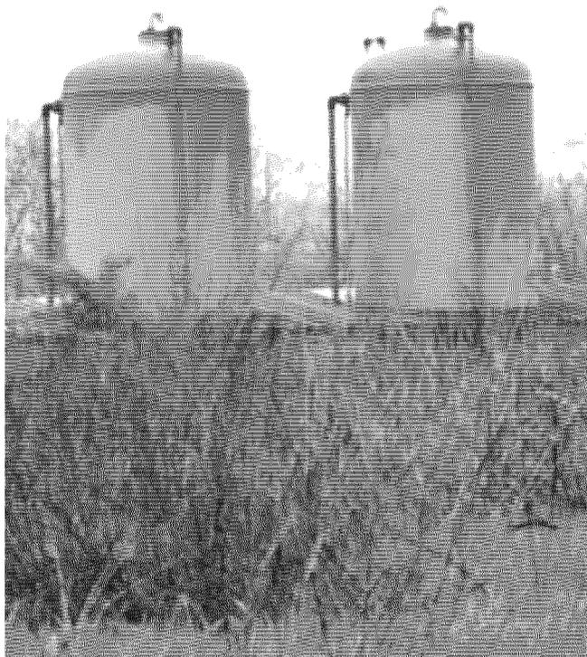
I silos di raccolta del percolato delle scorie radioattive di Capriano
