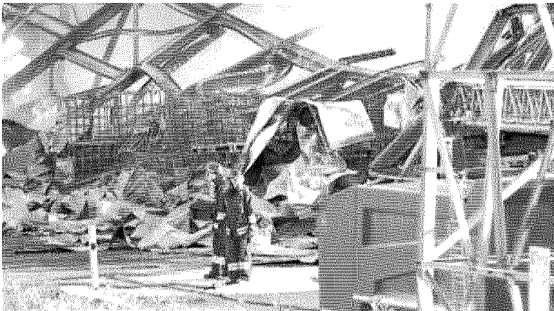
▲ Al lavoro I vigili del fuoco dopo aver spento le fiamme alla Silo
