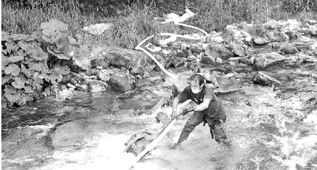
Si stendono i tubi per togliere il gasolio dalla pozza
