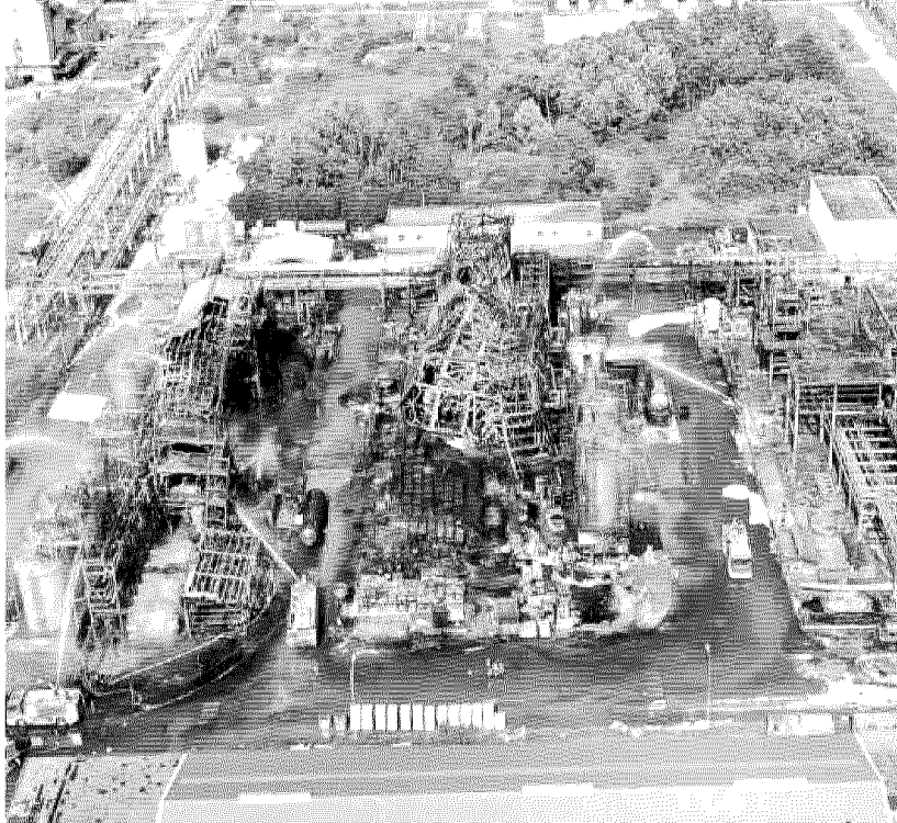
Quello che resta della 3V Sigma dopo il furioso incendio del 15 maggio
