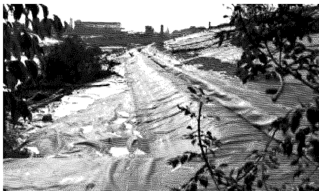
Uno scorcio della discarica di Ca' Filissine
