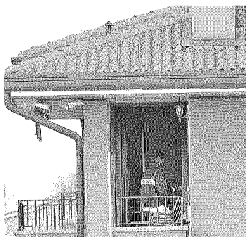
I vigili del fuoco nella palazzina di via Piave a Mezzavia, invasa dal monossido di carbonio (FOTOPIRAN)
