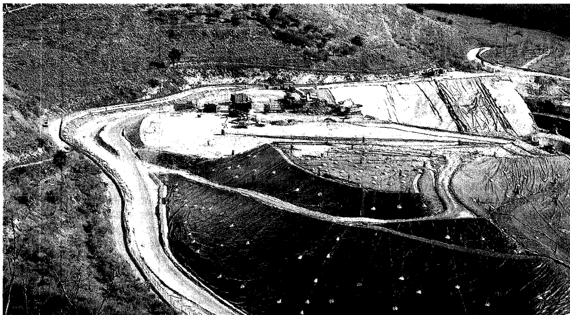
Contrada Zuppà L'ex discarica comprensoriale: disposto altro prelievo di percolato
