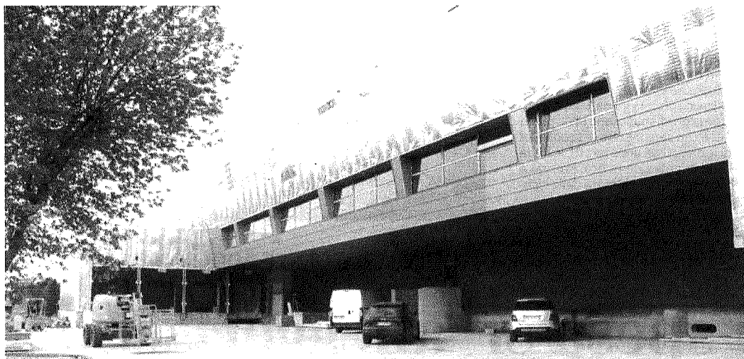
OSPEDALETTO L'esterno dello stabilimento Carnitalia, che venne distrutto da un incendio nel febbraio del 2015
