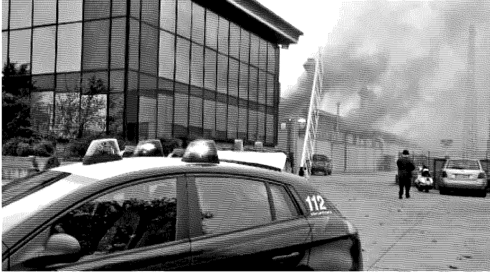
Danni ingenti a causa dell'incendio scoppiato ieri mattina all'interno della ditta Europlan. CISCATO
