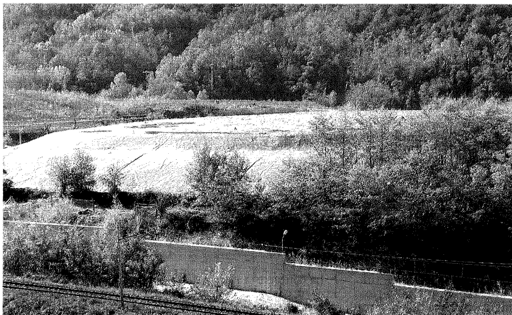
Uno dei "lagoons" del sito Acna che accoglie i terreni contaminati provenienti dai lavori di bonifica.
