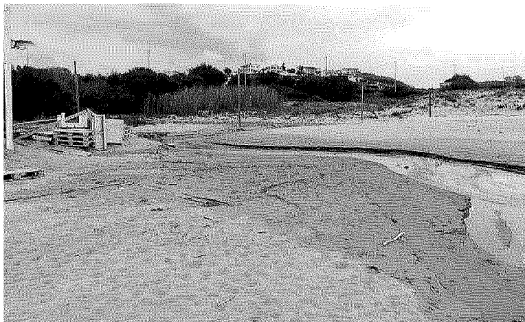
Cattivi odori. Lo sversamento fognario che attraversa la spiaggia di San Leone
